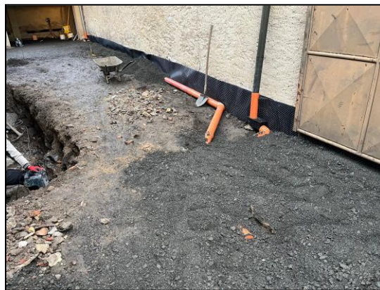
Odvodnění dvora.
