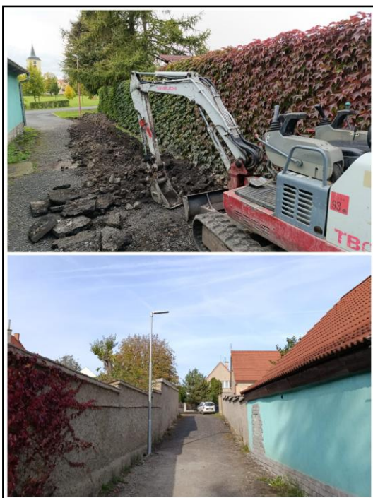
Bagrování příkopu pro natažení nových elektrických kabelů a fotografie nové lampy.
