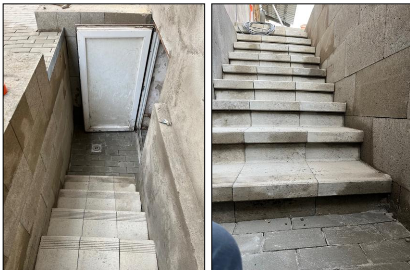
Rekonstrukce schodiště vedoucího do sklepa.
