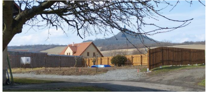
Přípravné práce na pozemku, oplocení parcely.
