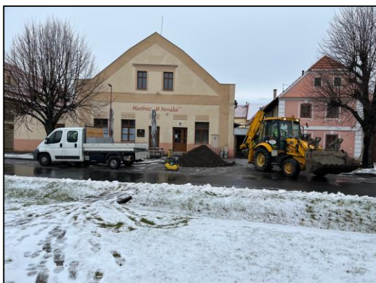
Pohled na hostinec a začátek stavebních prací.
