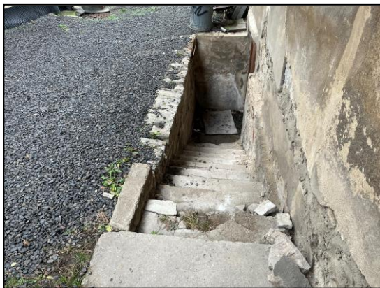
Stav schodiště před rekonstrukcí.
