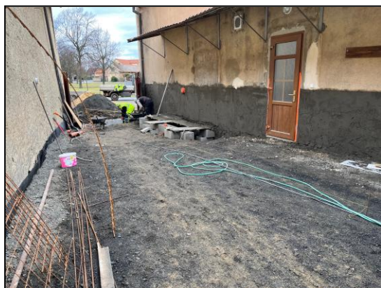
Příprava dvora na položení zámkové dlažby.
