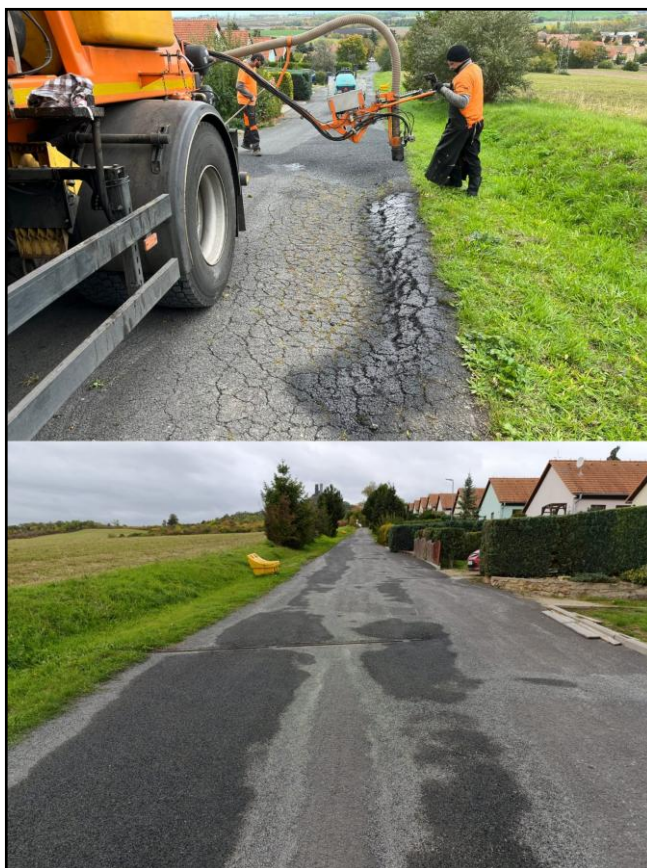
Firma při práci a opravená silnice.
