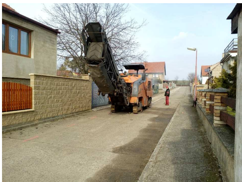
Stoka AB - frézování ulice ke Kvapilům - únor 2019
