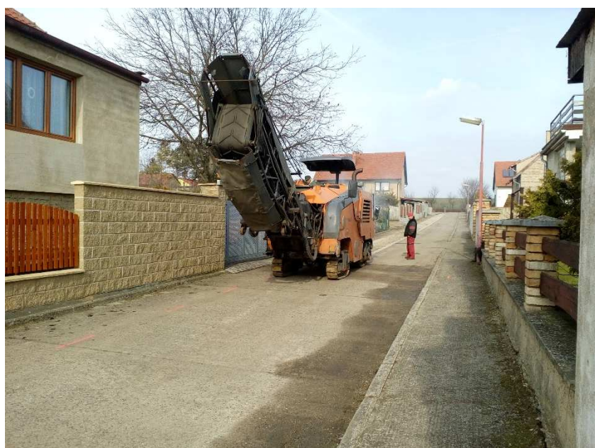
Stoka AB - frézování ulice ke Kvapilům - únor 2019
